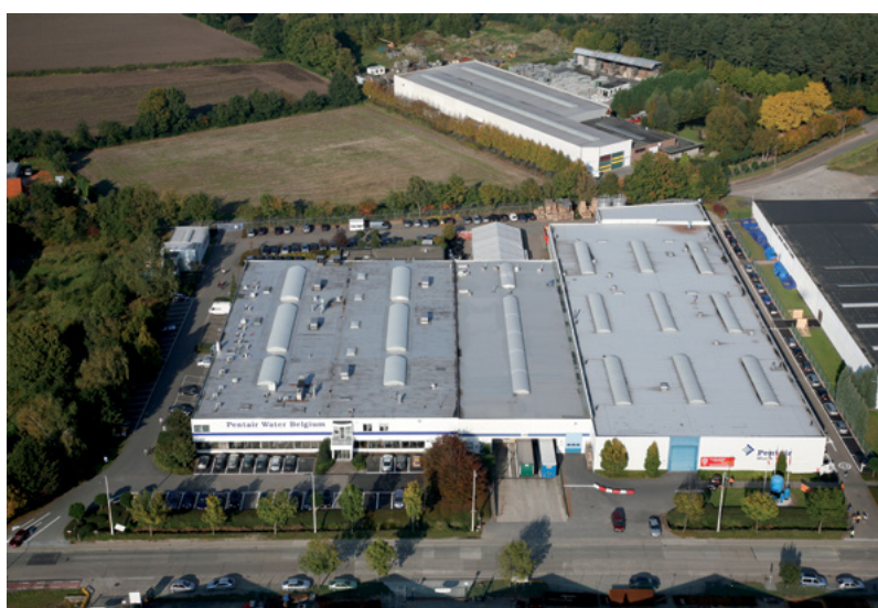
Site de production de Structural Herentals. Belgique
